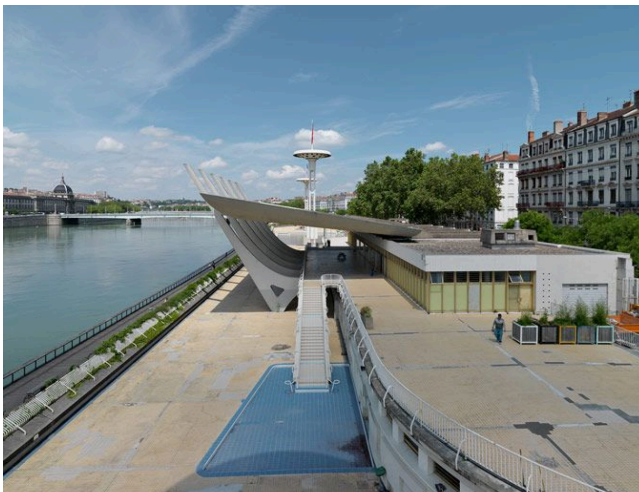
Vue du bâtiment d'exploitation depuis le sud (état en juin 2012).
