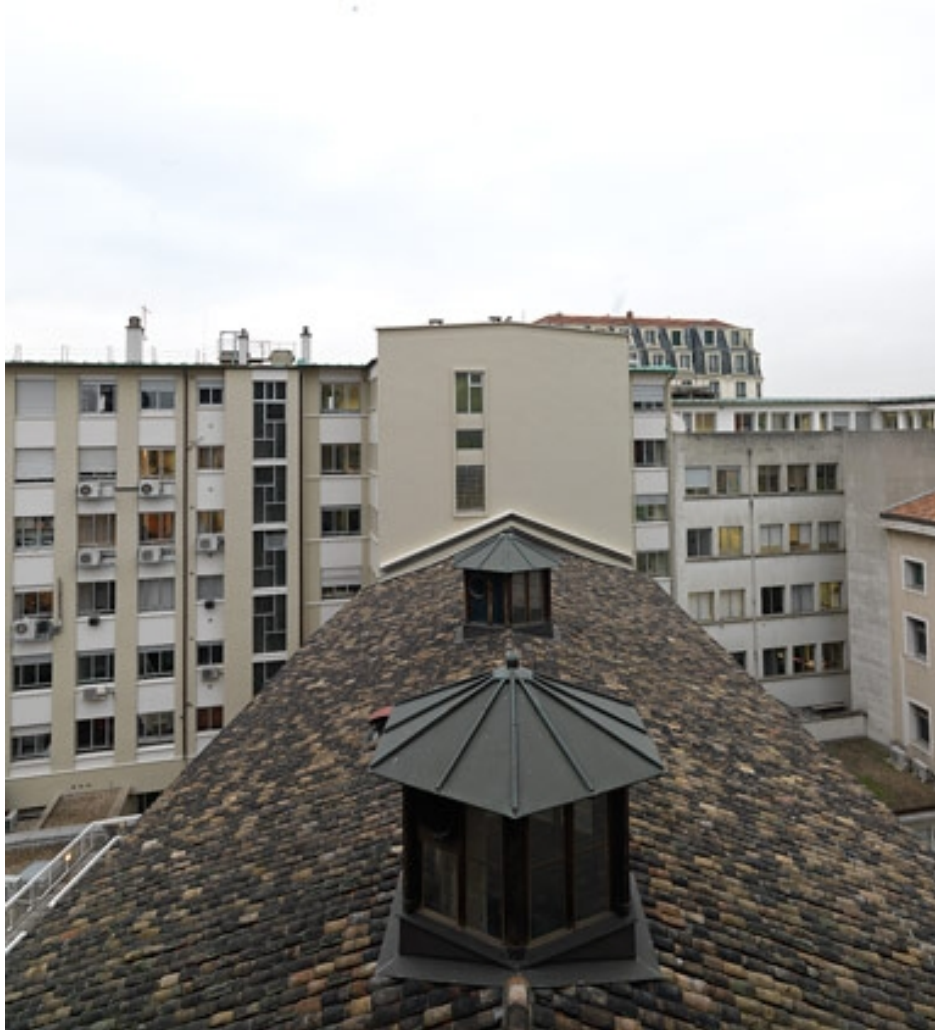
Bâtiment O. Vue de la toiture depuis le sud
