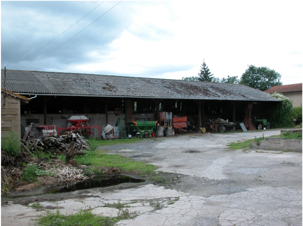
Vue du côté sud de la cour.
