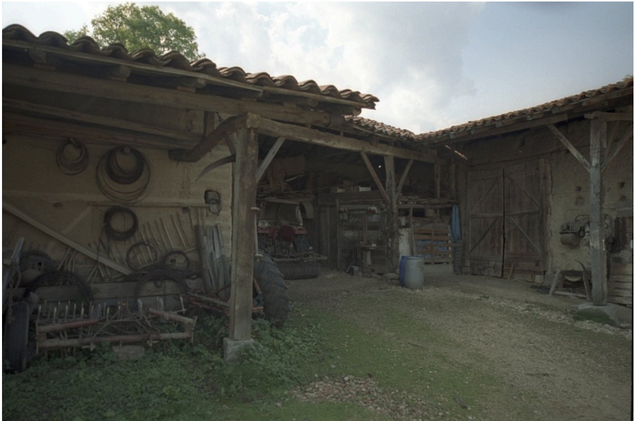
Cezay, Marcy (1987 B2 559), type A1. Vue d'ensemble des communs.
