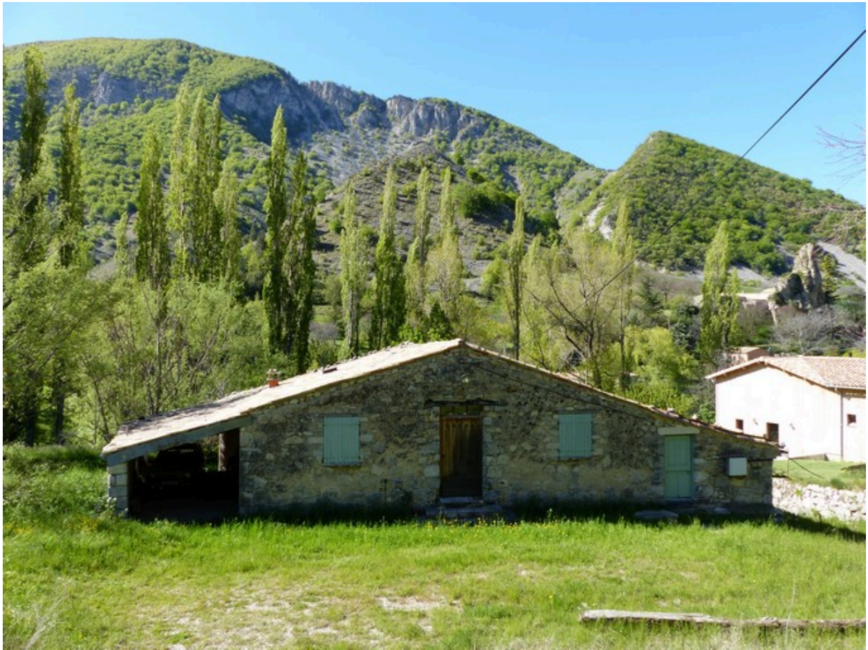
Vue d'ensemble prise du nord.
