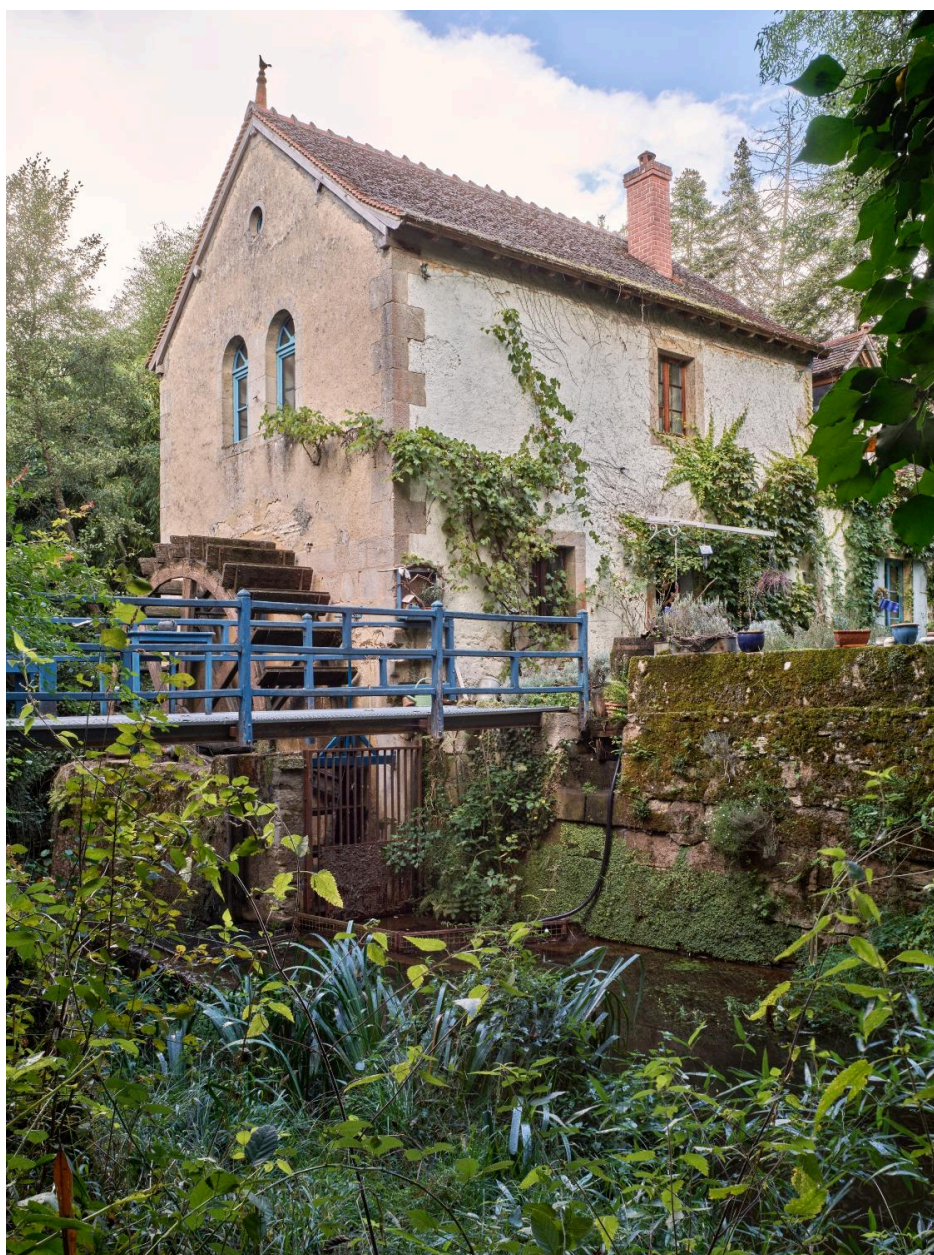
Vue du sud ouest.
