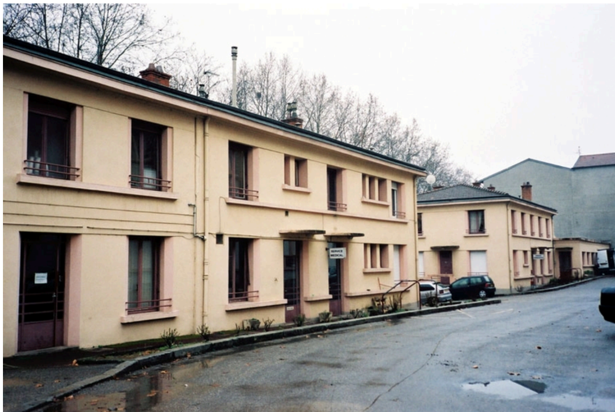
Vue d'ensemble nord-ouest des pavillons d'entrée
