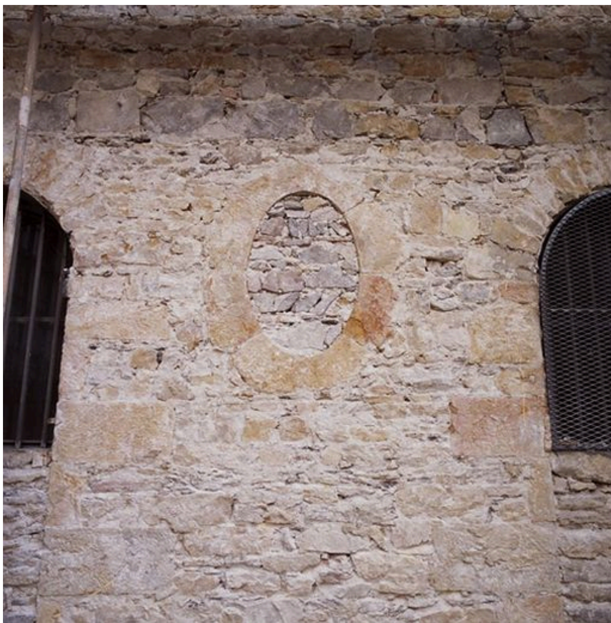
Grand cloître, galerie ouest, partie sud donnant sur la place des Chartreux durant les travaux de mars 2002, détail de l'oculus ovale entre deux travées
