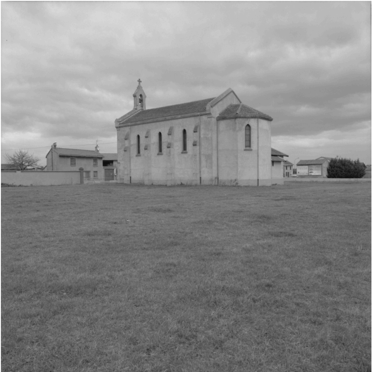
Vue d'ensemble de trois-quarts depuis le sud-ouest.
