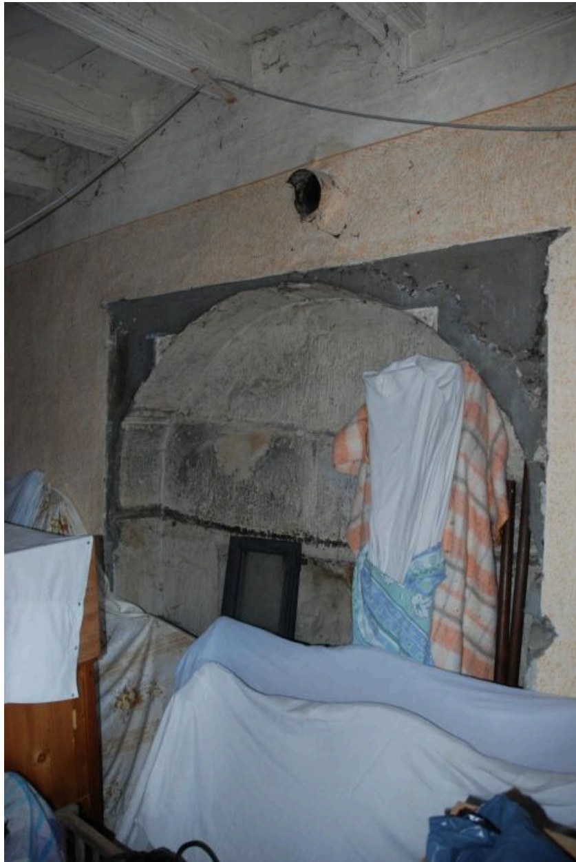
Vue intérieure de la première chambre : "bretagne".
