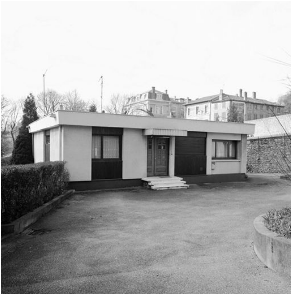
Pavillon de logement du directeur (32), façade nord
