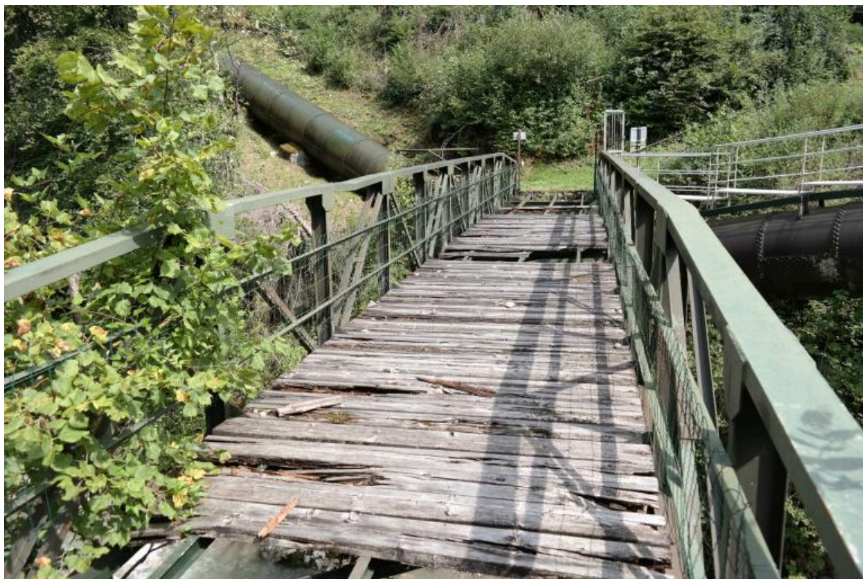
Passerelle EDF de Bioge, vue du tablier
