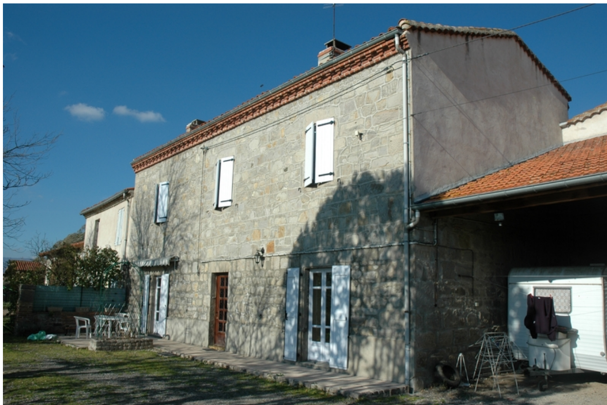
Vue d'ensemble du grand logis.
