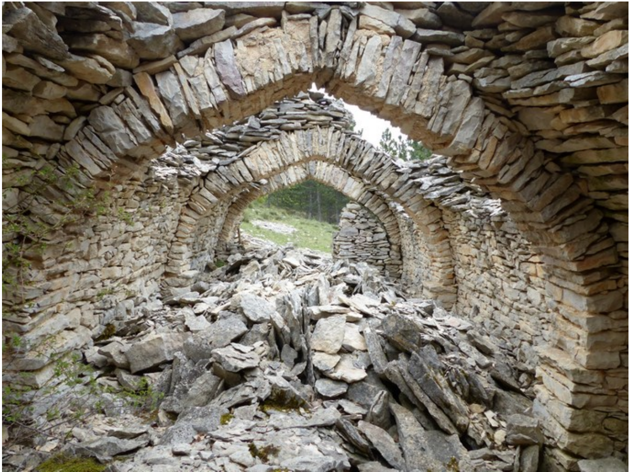
Vue de volume prise du nord.
