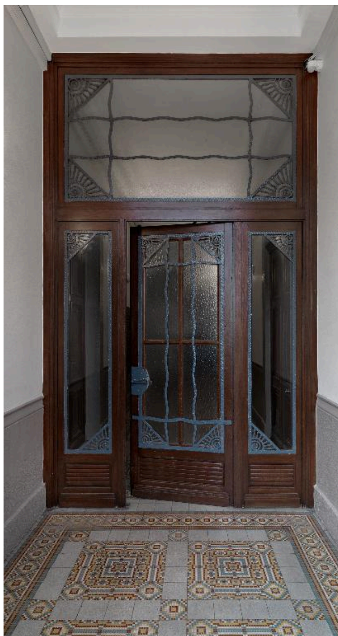
Vue intérieure : le vestibule-sas et la porte intérieure
