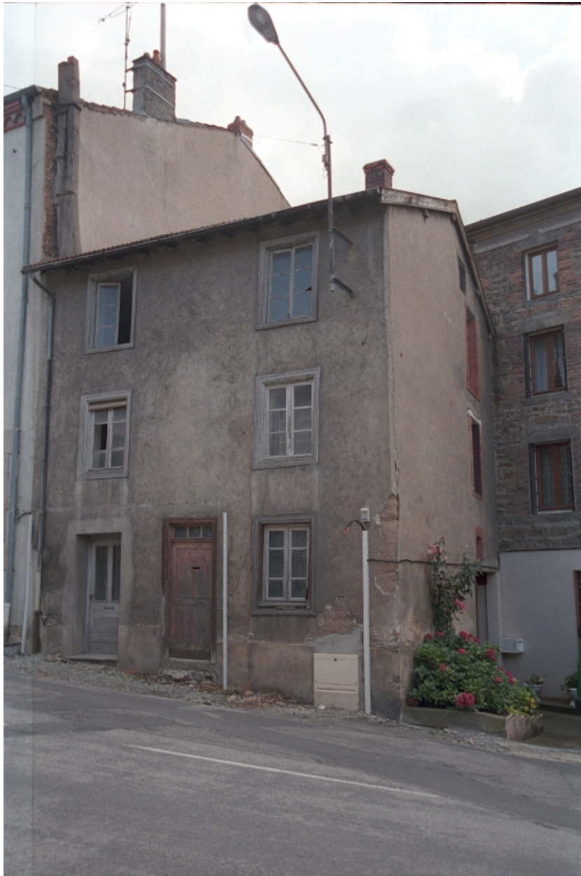
Le Bourg, maison (1986 C2 702), vue d'ensemble de trois-quarts.
