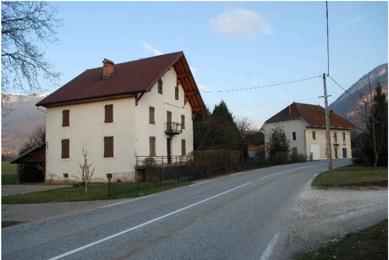
A3 322, Ouchettes-sud (les), ferme. Vue d'ensemble de trois-quarts avant gauche.
