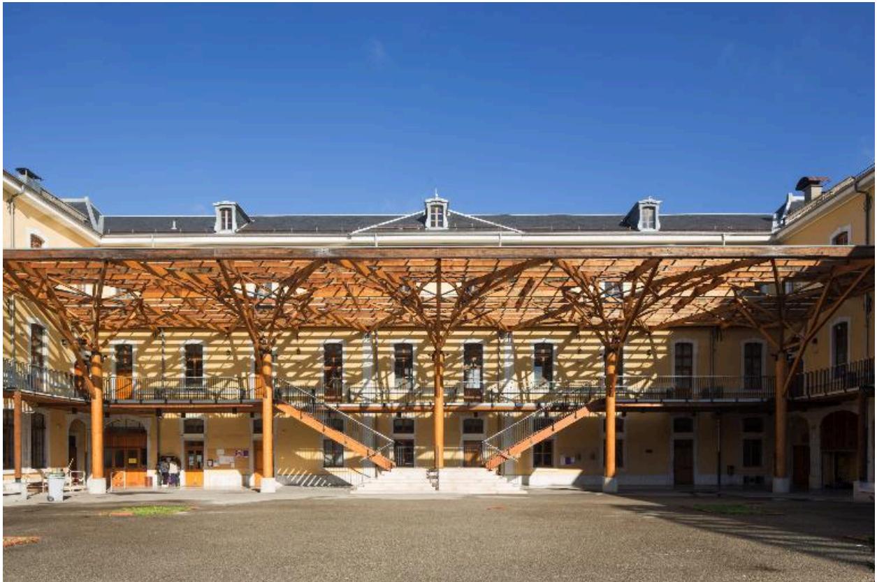
Galerie sous coursières : vue d'ensemble.
