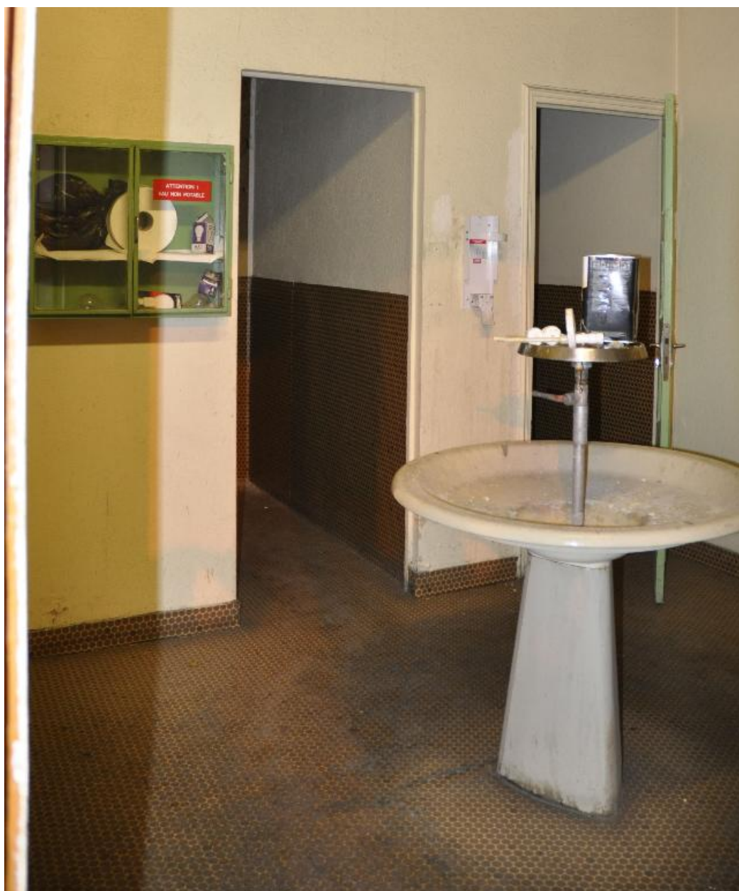
Vue des sanitaires de la centrale de Livet
