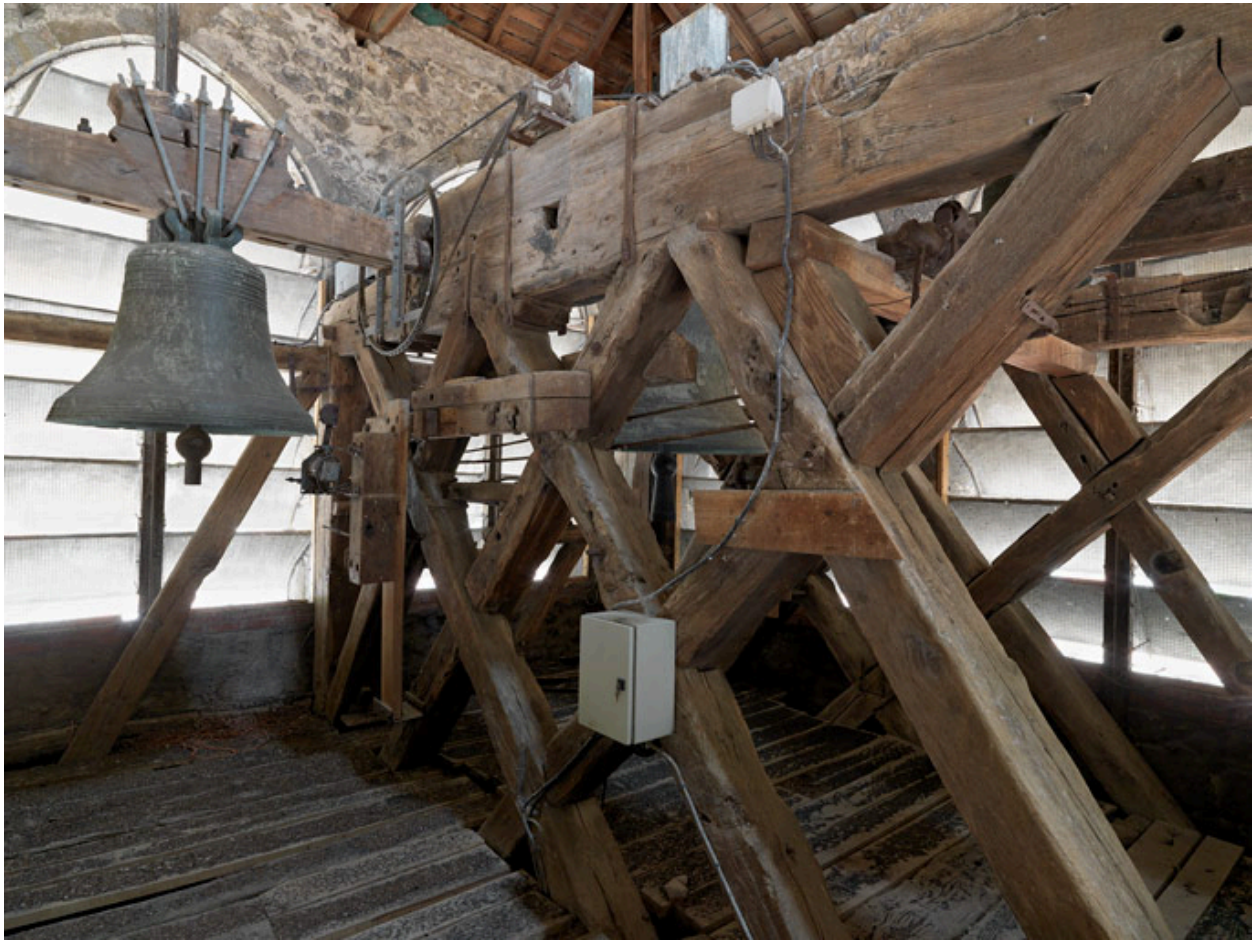
Vue générale dans le beffroi.
