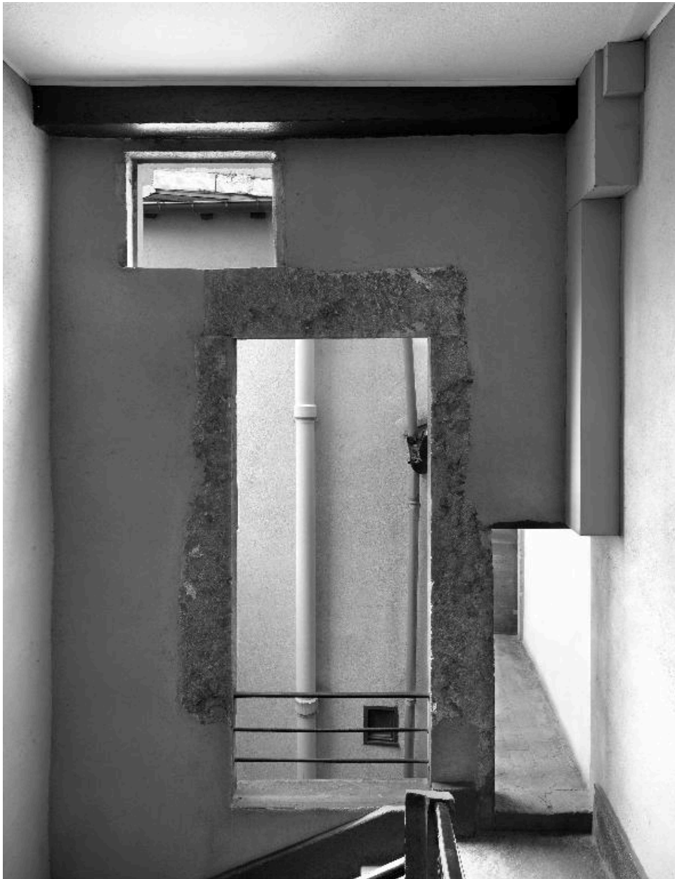
L'escalier nord : baies libres ouvrant sur la cour, dernier étage
