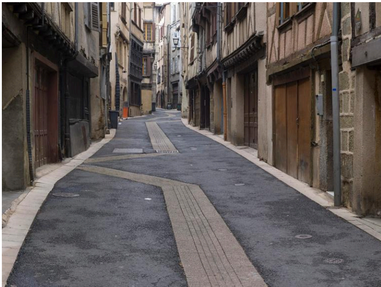
Vue partielle de la rue, au niveau des rez-de-chaussée.
