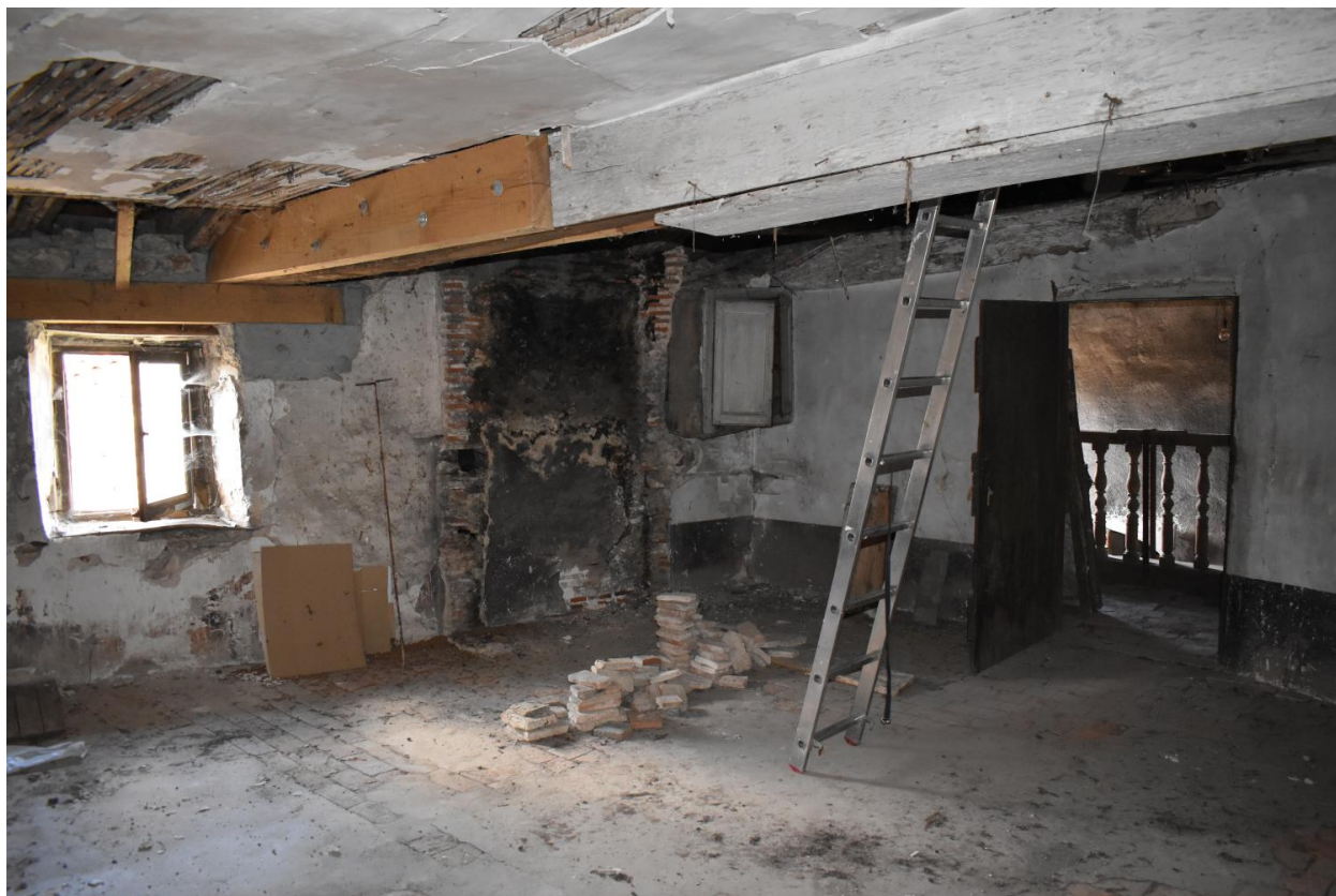
étage de comble. Vue d'ensemble de l'espace B vers l'angle nord-est.
