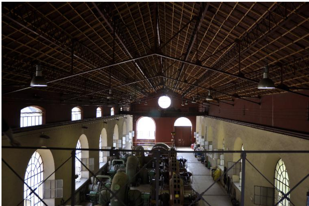
Vue de la salle des machines
