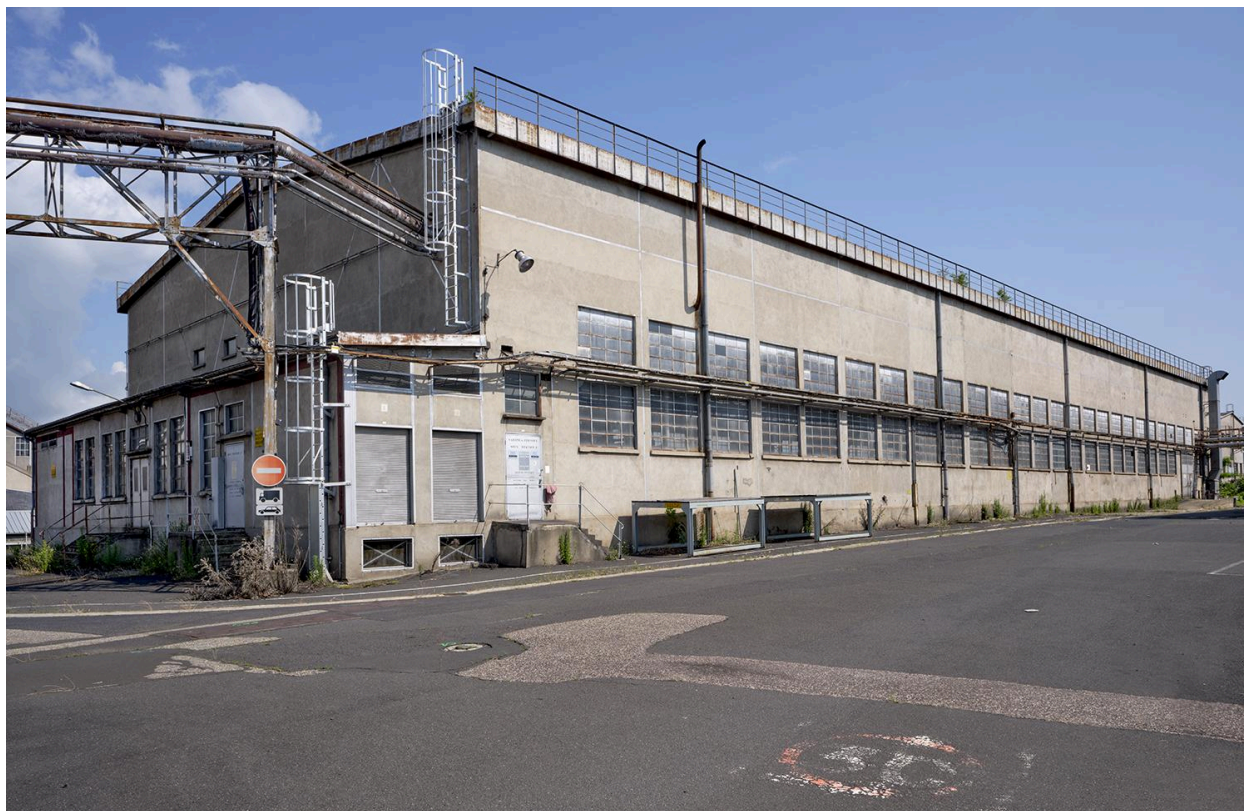
Bâtiment F4, dit Halle F4, depuis le sud.
