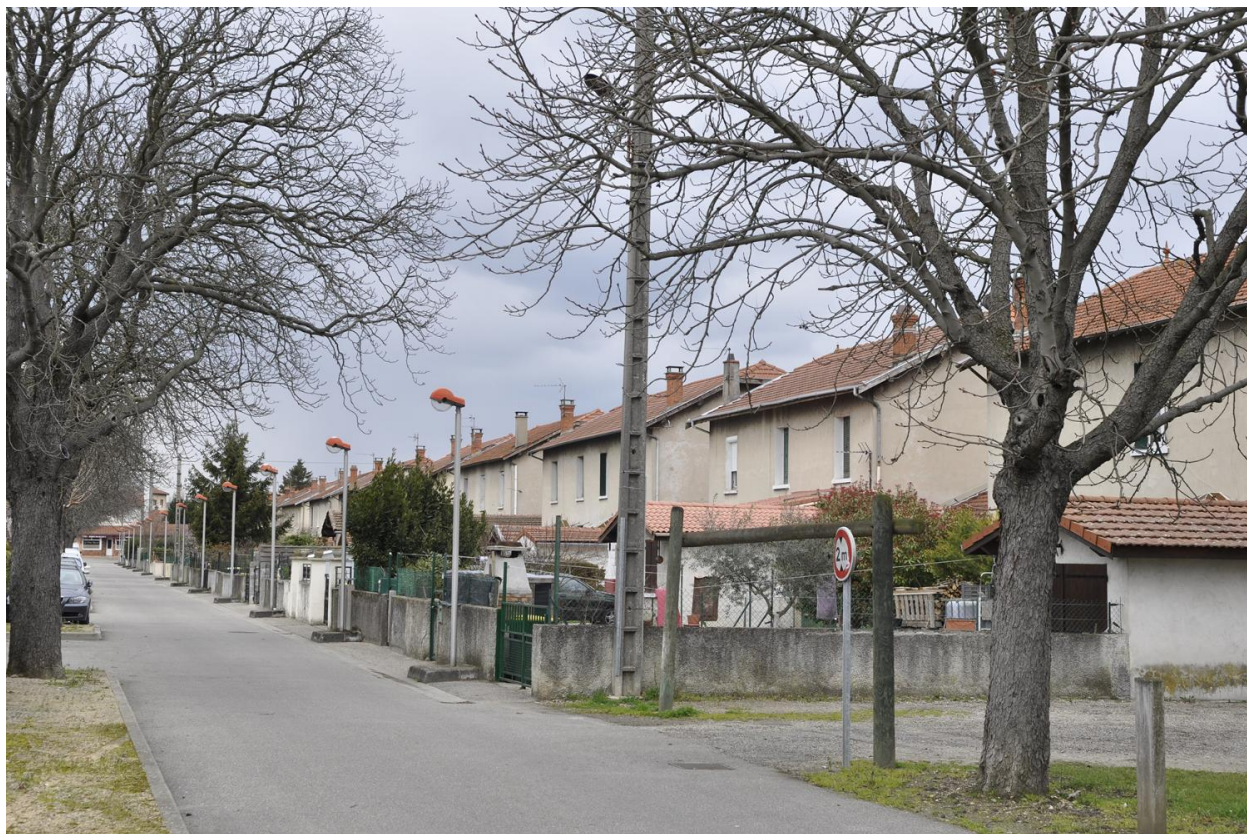
Vue d'ensemble de maisons ouvrières des cités de Roussillon
