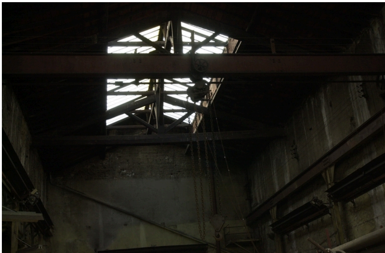
Vue intérieure des ateliers, charpente, lanterneau et pont roulant
