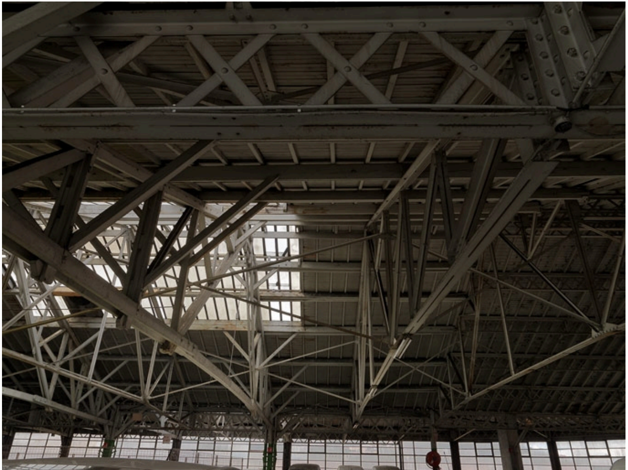
Vue est de la charpente (5e étage)
