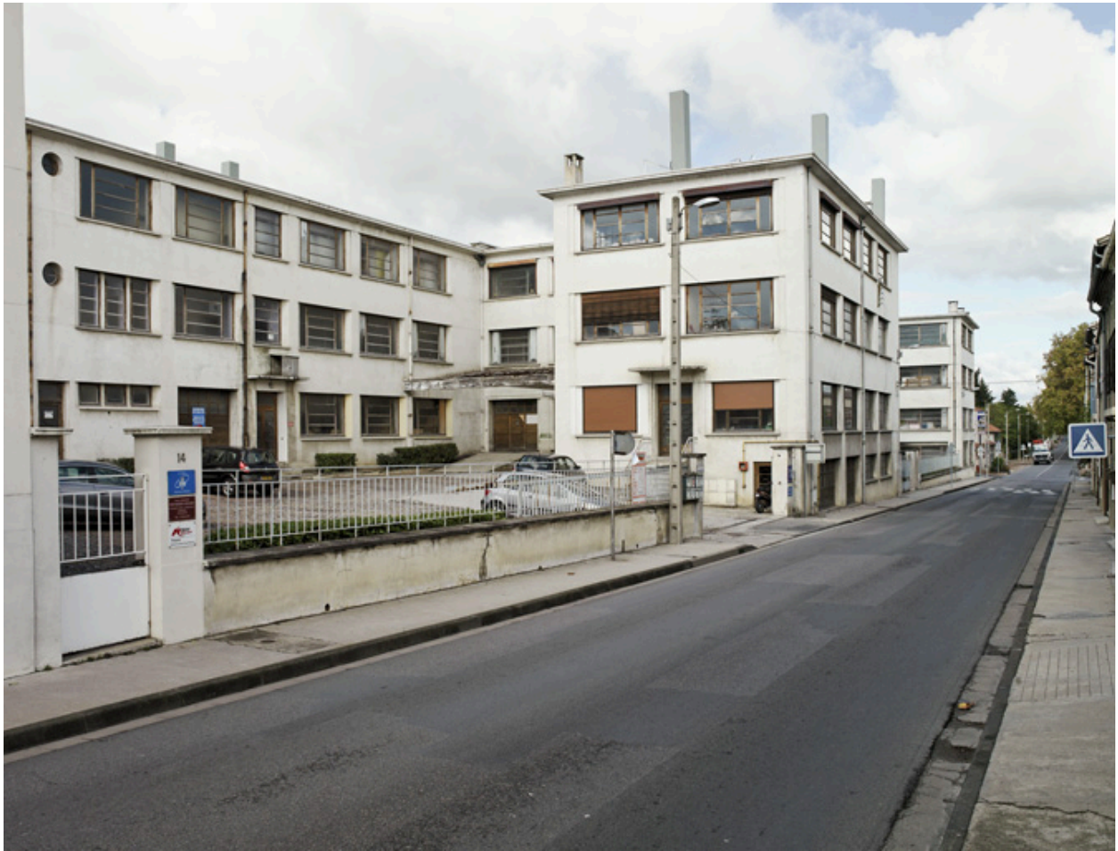
Vue d'ensemble depuis le sud-est des bâtiments d'entrée de l'usine GÉGÉ.
