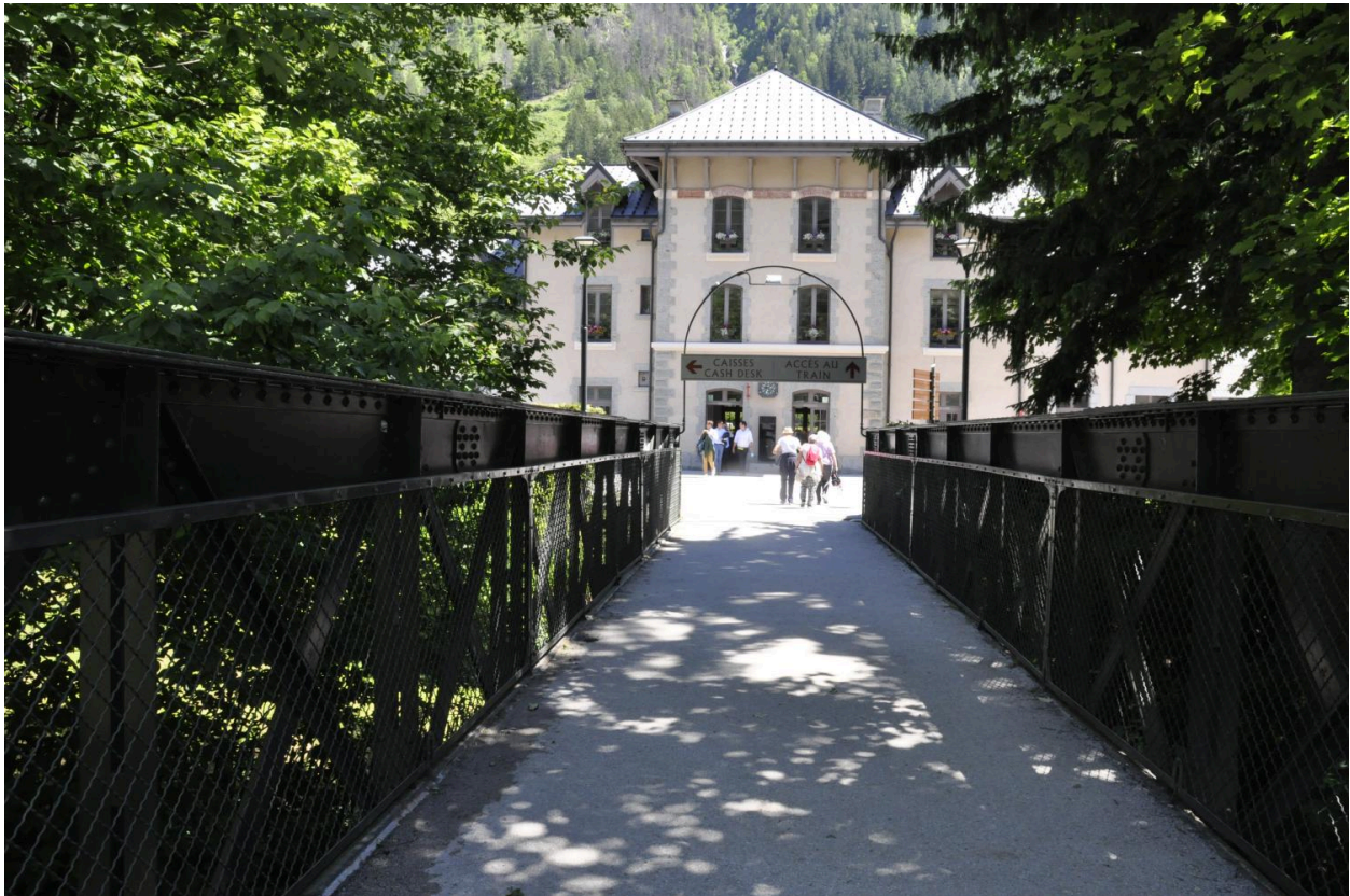
Vue de la gare basse du Montanvers
