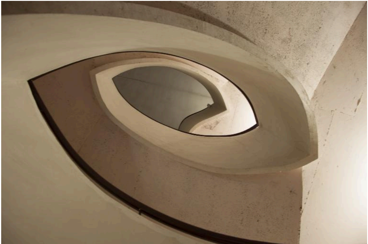
Vue de l'escalier de distribution depuis le bas
