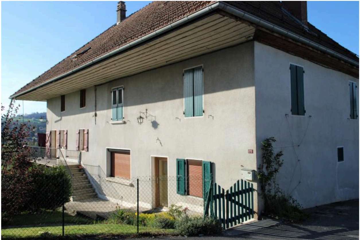
Cusy, B2 83, 86, ferme. Vue d'ensemble de la façade principale.
