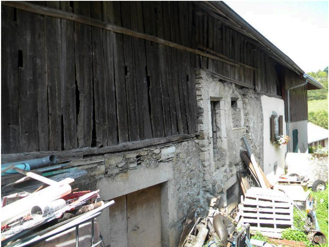
Vue de la façade sud-est
