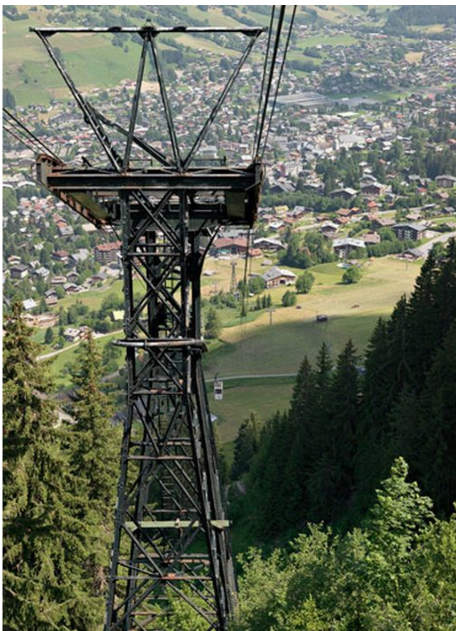
Vue d'un pylône depuis l'amont
