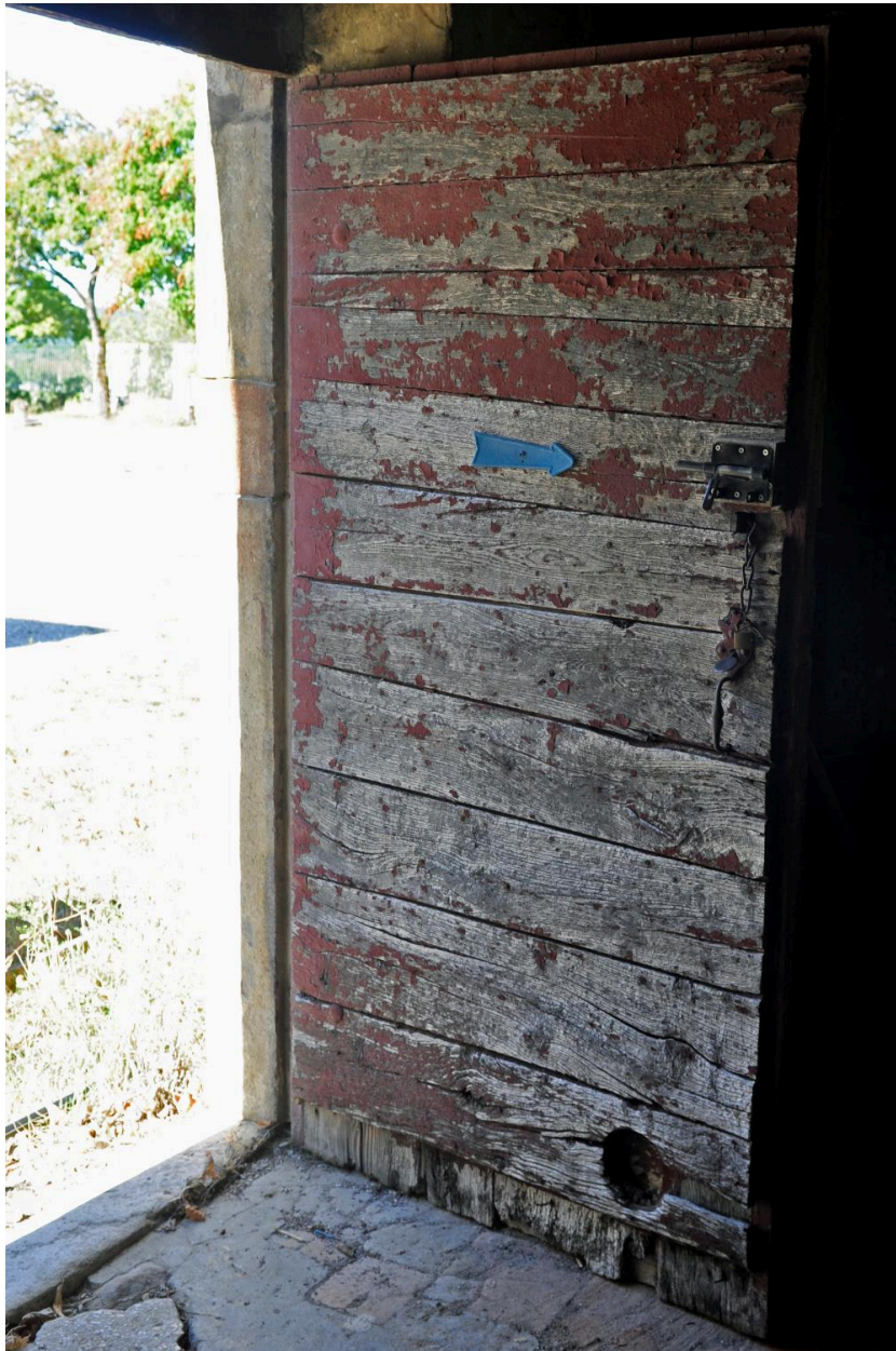
Détail de menuiserie de la porte
