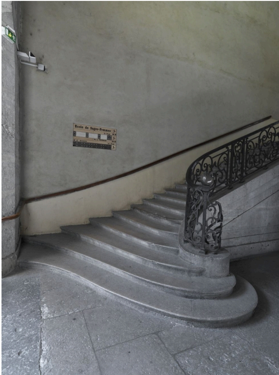
Bâtiment E. Départ du grand escalier
