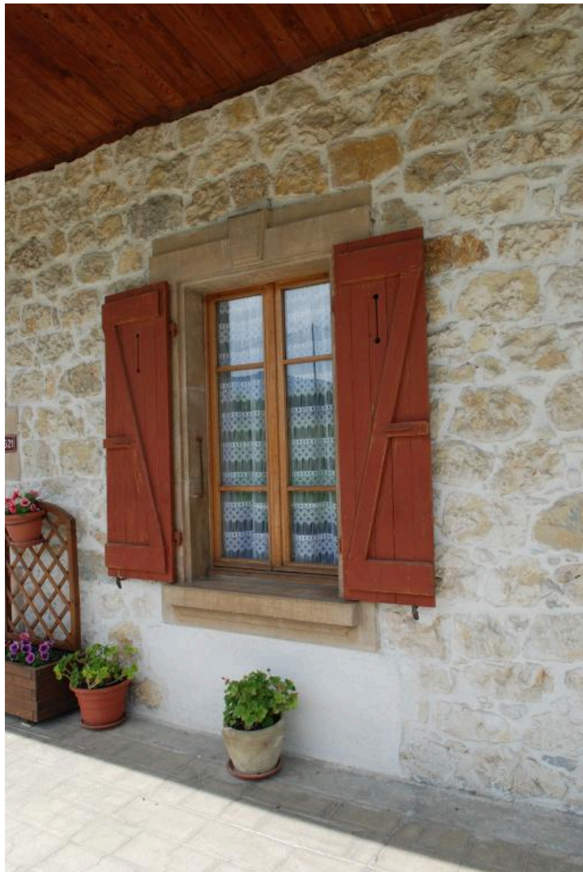
Détail d'une des fenêtres.
