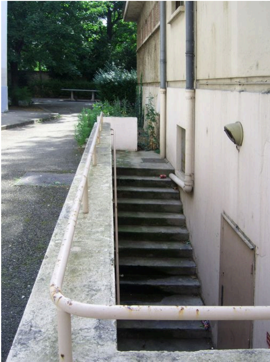
Escalier postérieur menant au sous sol
