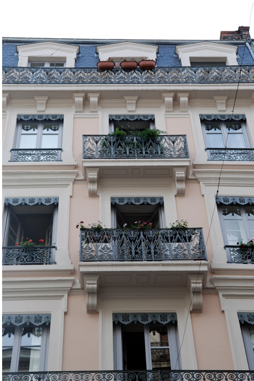
Elévation rue Gasparin : vue partielle
