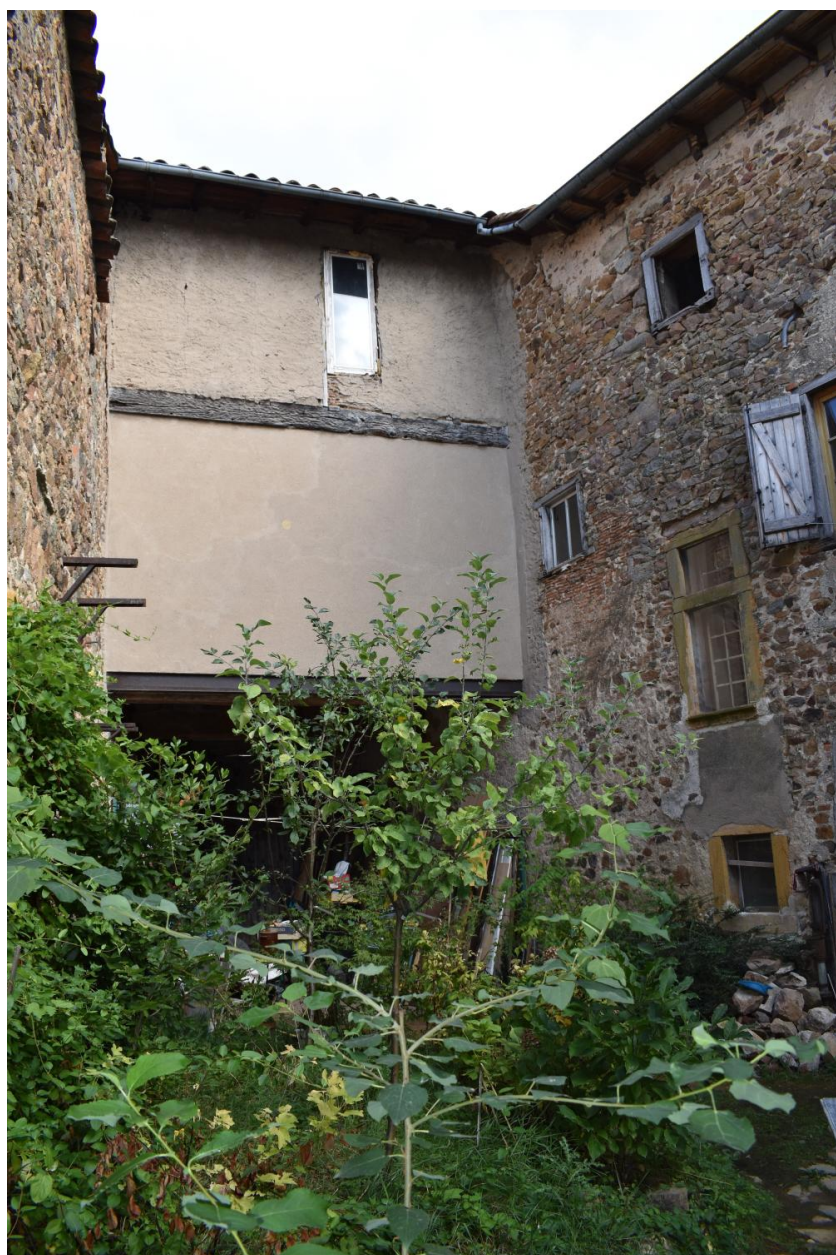
Elévation arrière du retour, sur cour, de la maison.
