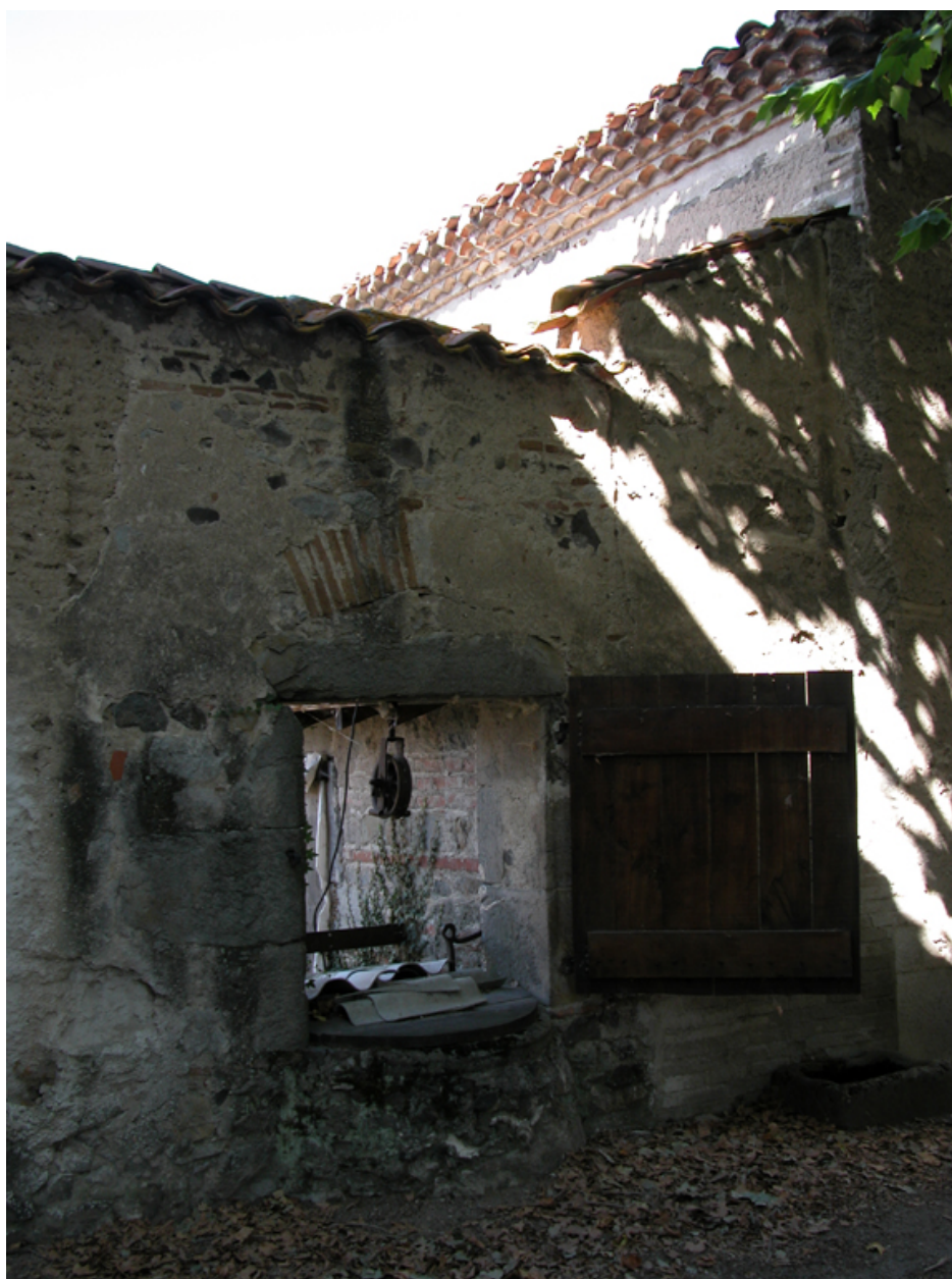
Vue du puits mitoyen.
