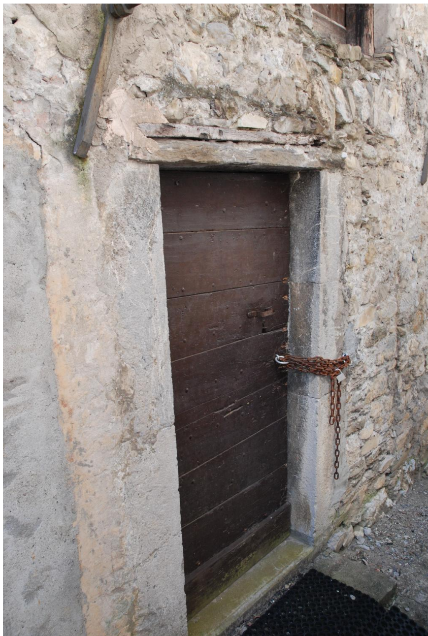
Vue de la montée de l'Ouille, celliers dits "sartos" (2018 H2 309, 310).
