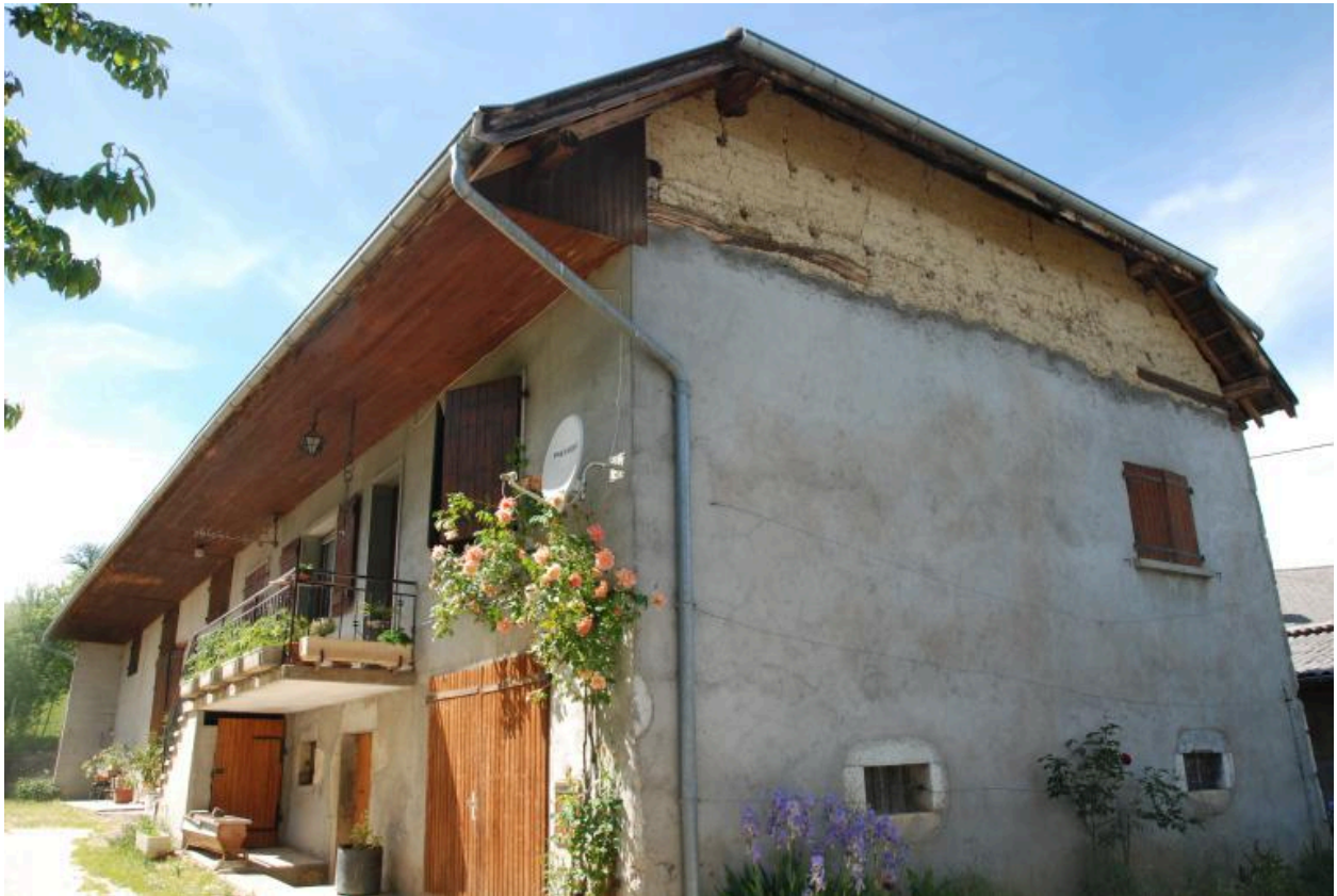
Ferme (2016 A6 437), non repérée. Partie supérieure du mur en pisé.
