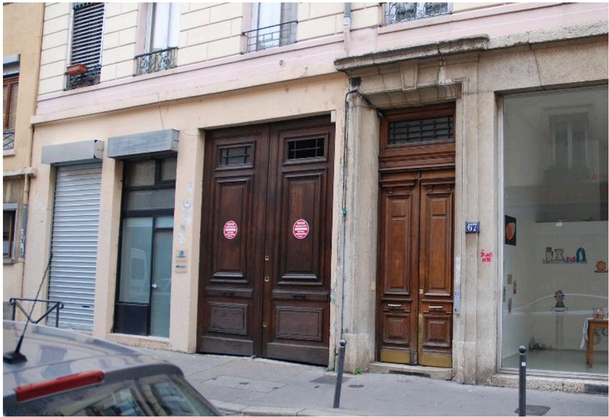
Elévation ouest : porte bâtarde et porte cochère juxtaposées
