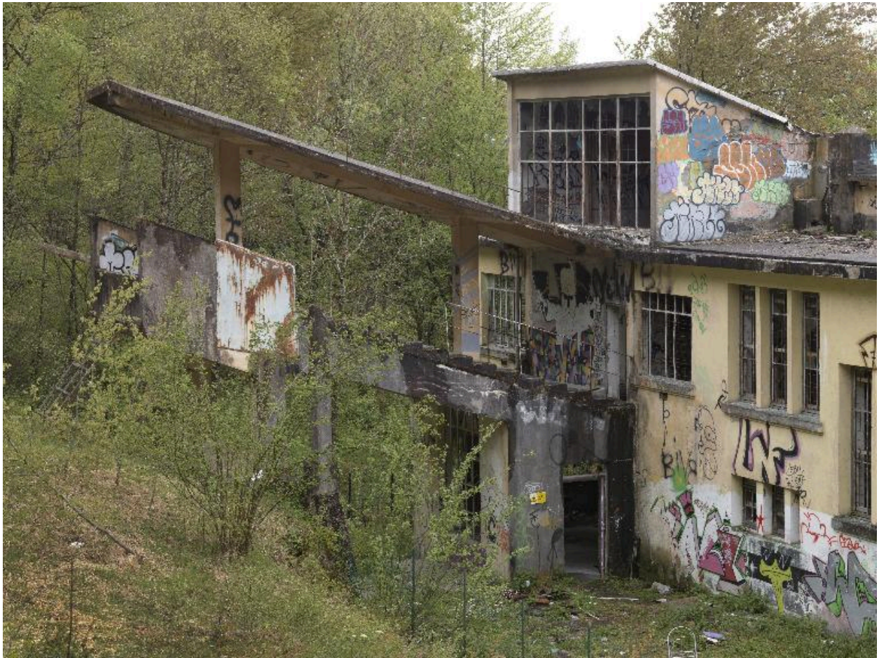
Escalier extérieur d'embarquement
