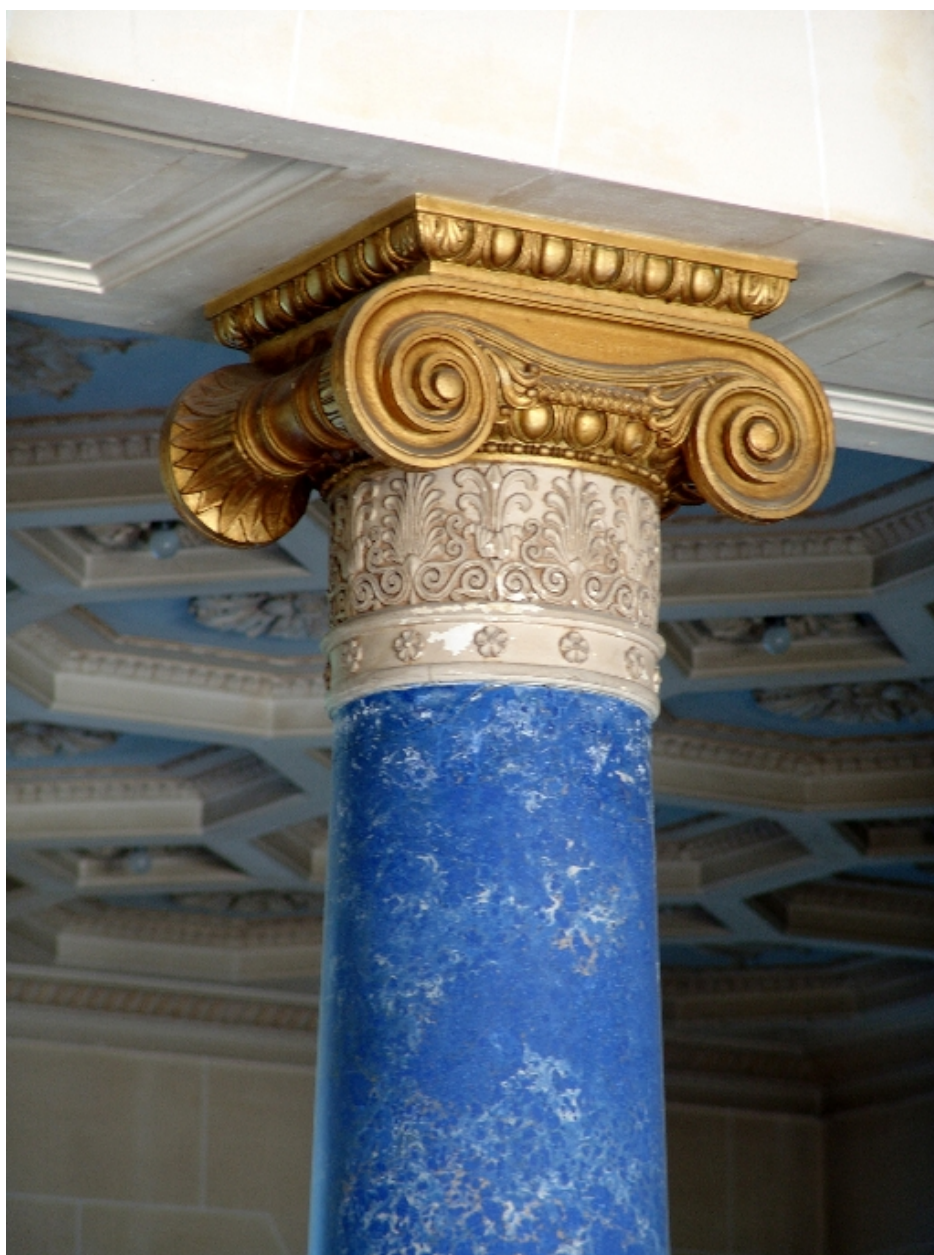
Chapiteau d'une colonne du hall
