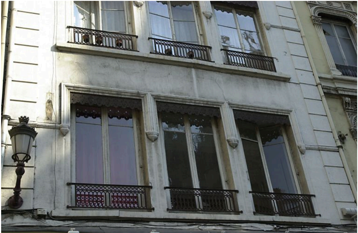
Façade principale, détail des fenêtres du 1er étage
