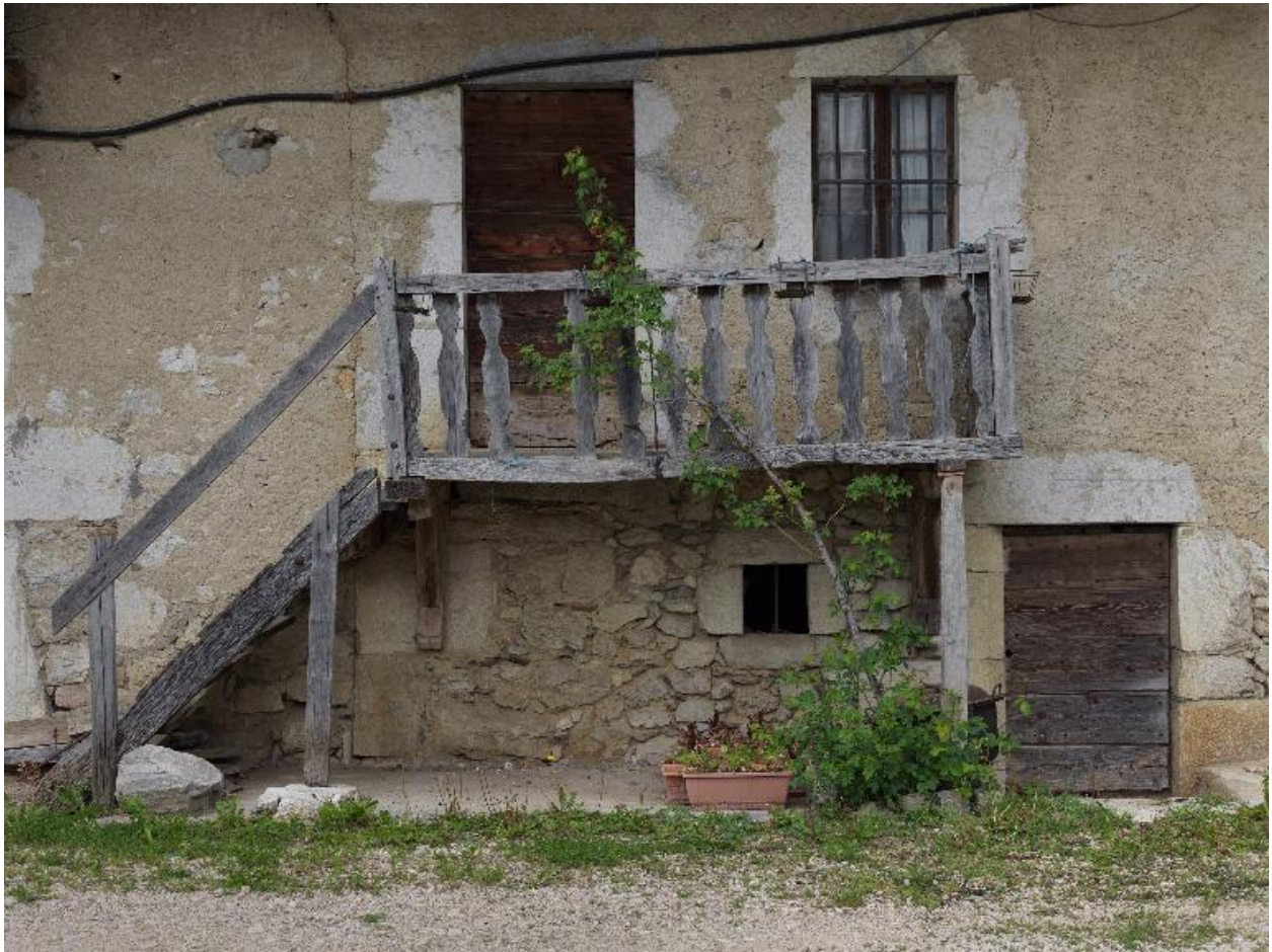
Détail de la partie entraine de la ferme, accès au logis.
