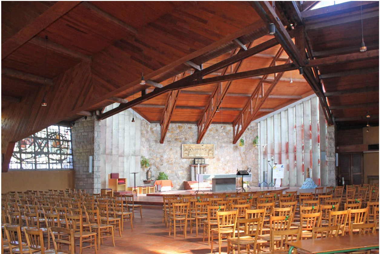
Brioude, chapelle de la Borie Darles, la nef et le chœur vus depuis l'angle sud de la nef.
