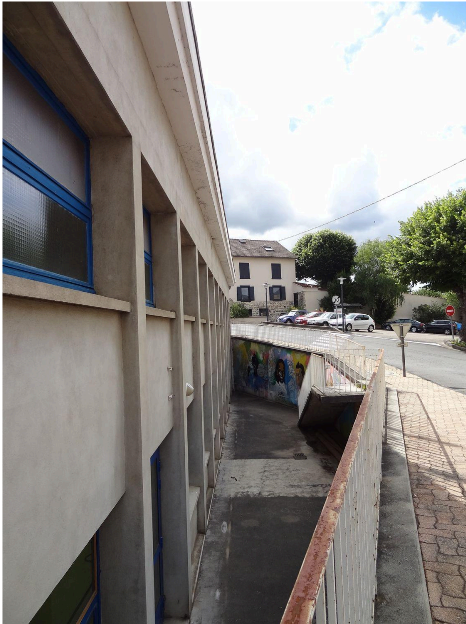
Vue de la cour-anglaise située en façade du gymnase.
